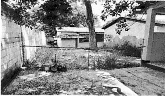
SUSTITUCION DE MURO PERIMETRAL
